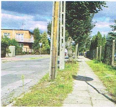
Jeden z wniosków dotyczy budowy chodnika przy ul. Partyzantów
