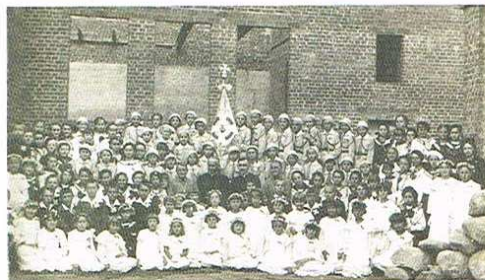
Rok 1928 – Trwają prace przy budowie kościoła, działa 4-klasowa szkoła, jej uczniowie uczestniczą w krucjacie eucharystycznej. Budowę kościoła kieruje inż. Olearski (na zdj., – z teczka)
