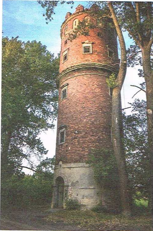
Kolejowa wieża ciśnieni na Bugaju przy stacji PKP Foto: Damian Redlicki
