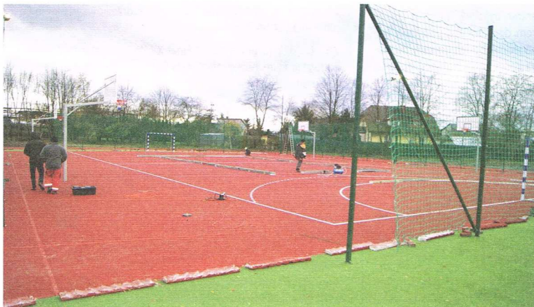
Ostatnie prace na płycie boiska
