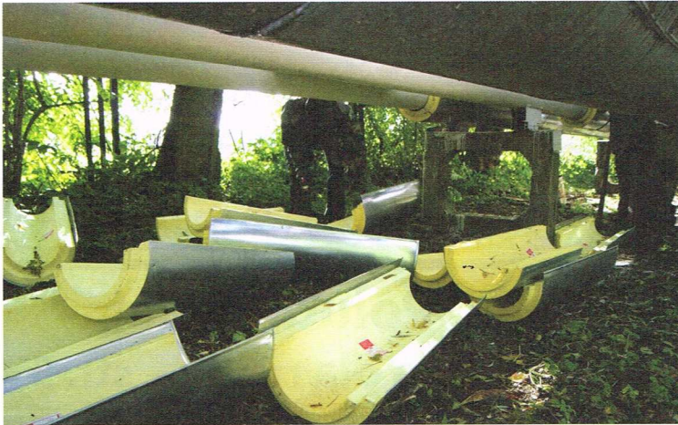
Prace przy wymianie izolacji
