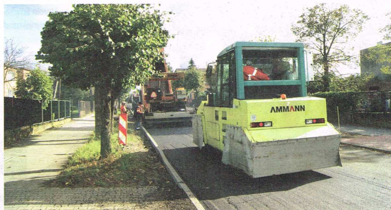
Prace na ul. Maszkowskiej
