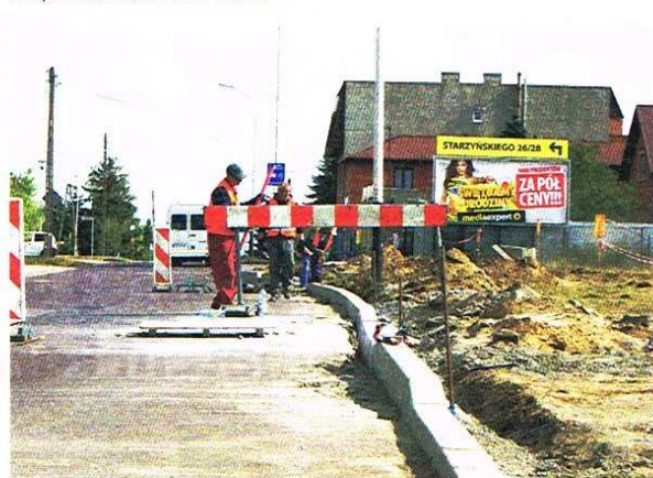
Budowa krawężnika na ulicy Sikorskiego
