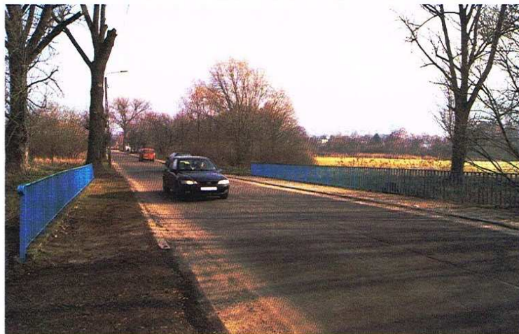
Most na Południowej zostanie przebudowany
