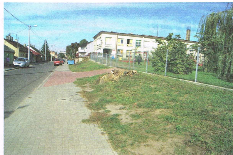
Budowa parkingu przy Przedszkolu nr 3
