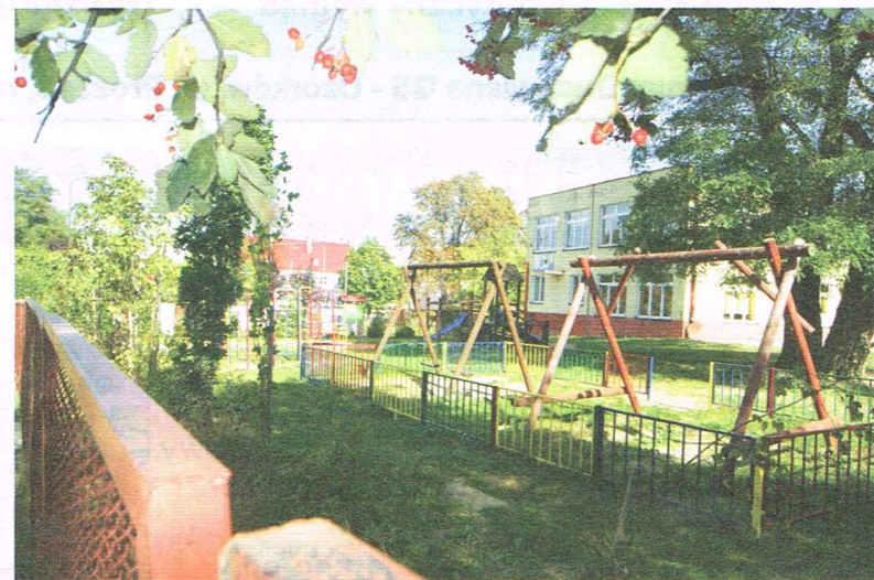
Budowa nowego placu zabaw przy Przedszkolu nr 5
