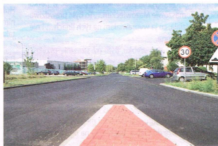
ul. Armii Krajowej - po remoncie
