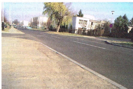
Chodniki przy ul. Mielczarskiego - przed remontem
