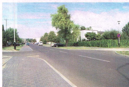
Chodniki przy ul. Mielczarskiego - po remoncie
