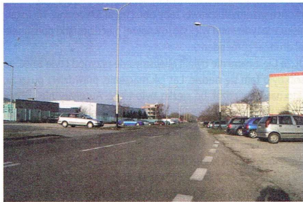
ul. Armii Krajowej - przed remontem
