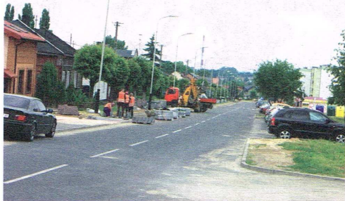
Prace przy układaniu chodnika na Mielczarskiego
