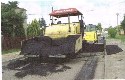
wylewanie asfaltu na ul. Grzybowej
