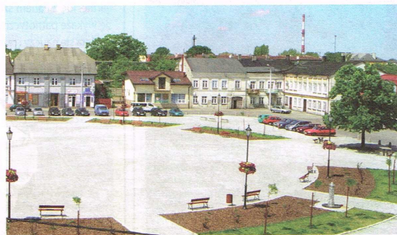
Modernizowane będą kamienice nr 13 i 14 (pierwsza i druga od prawej)
