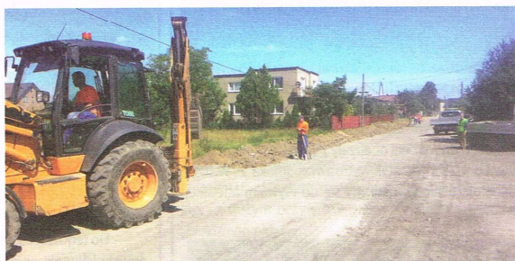
Prace na Grzybowej
