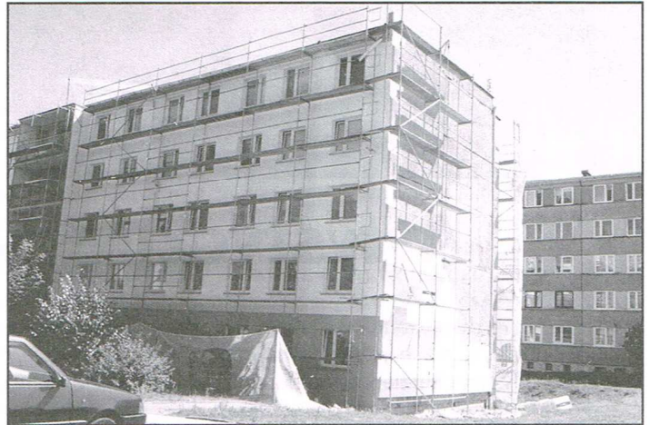
Termomodernizacja jednego z bloków przy ul. Mielczarskiego
