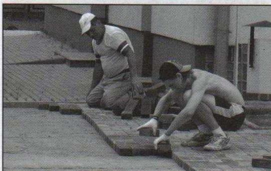
Układanie chodnika wokół hali
