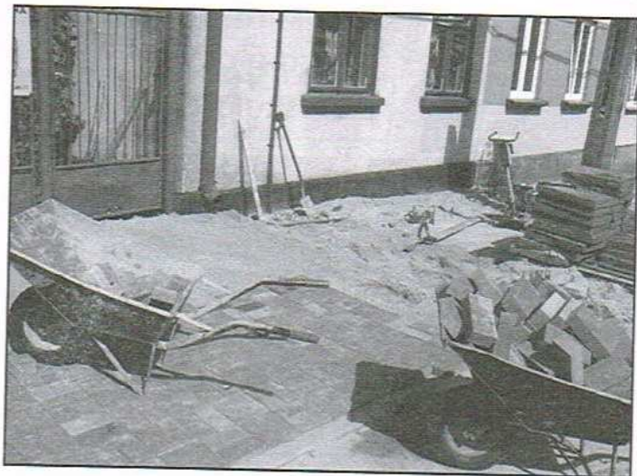
Prace na ulicy Bema
