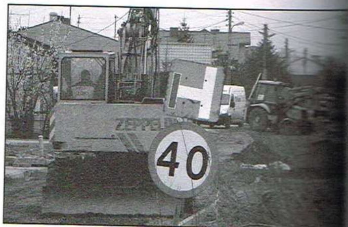
Roboty drogowe na ul. Gębickiej
