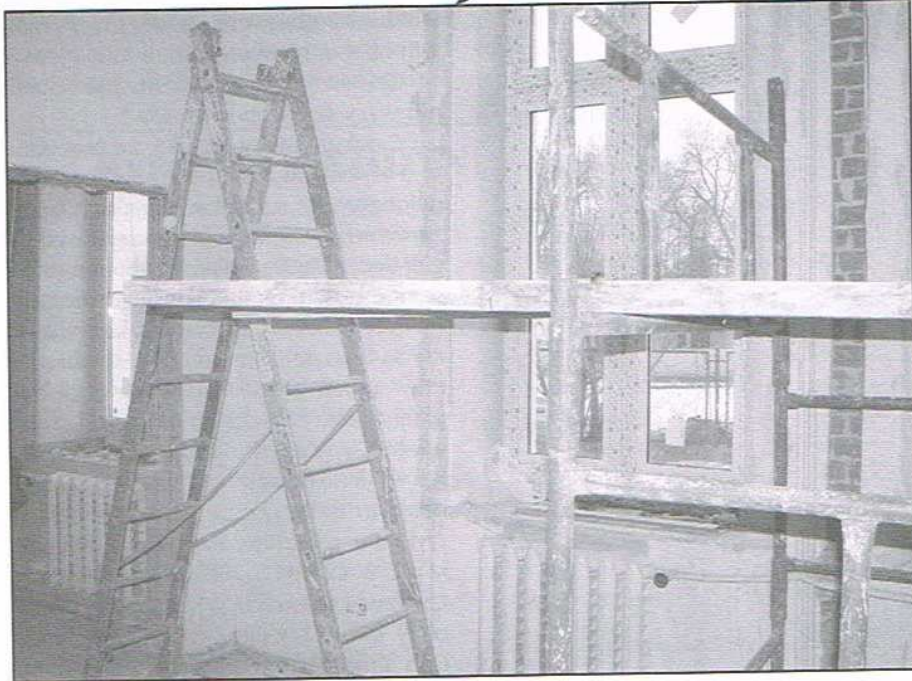
Remont w budynku przy ul. Listopadowej 16
