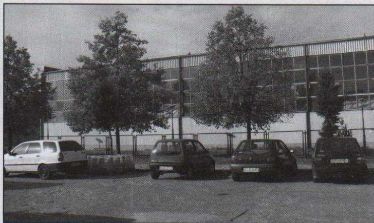
W tym roku zaplanowano wymianę okien na hali od ulicy Starzyńskiego
