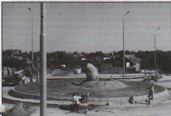
Prace na ulicy Unii powoli dobiegają końca
