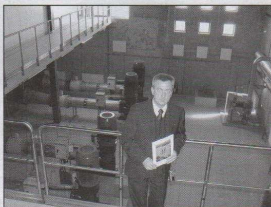
Burmistrz Piotr Giziński w zakładzie uzdatniania wody w Upplands Bro
