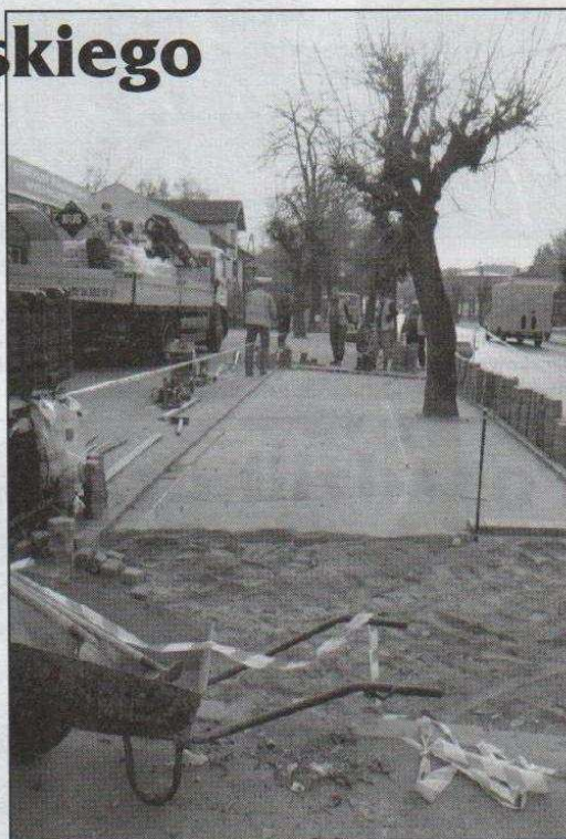
Na ulicy Starzyńskiego stare płyty chodnikowe wymieniane są na kostkę brukową
