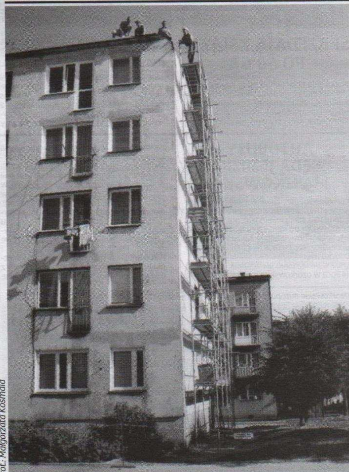
Obecnie prace remontowe trwają m.in. w bloku przy ul. Obrońców Westerplatte 2
