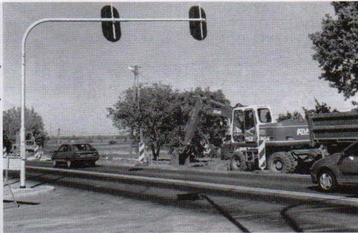
Roboty drogowe na obwodnicy dobiegają końca
