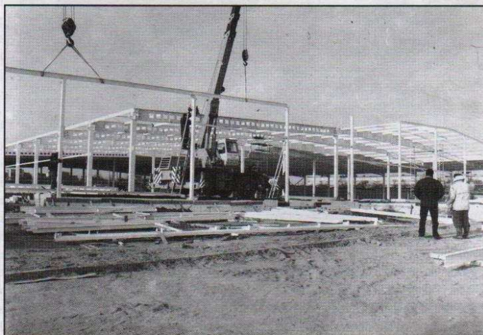
HTL Strefa Sp. z o.o. w budowie.
