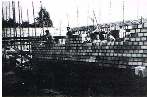
Budowa ściany frontowej strażnicy OSP w Solcy Wielkiej
