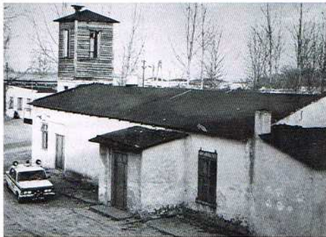
1984 rok – budynek starej remizy OSP Solca Wielka
