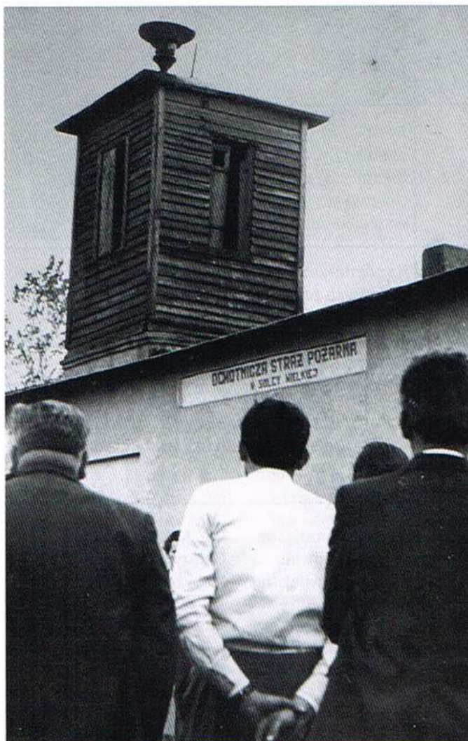
1978 rok. Remiza Ochotniczej Straży Pożarnej w Solcy Wielkiej
