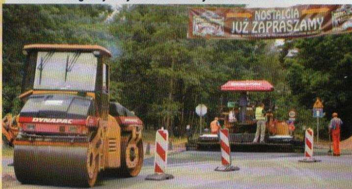
Budowa drogi Sokolniki Las - Helenów - Ozorków
