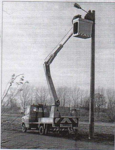
W miejscowości Leśmierz realizowana jest inwestycja w zakresie rozbudowy oświetlenia ulicznego tj. od magazynów
