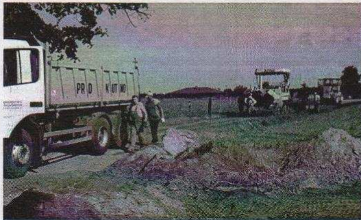
Na ukoczeniu są prace związane z budową drogi w Celestynowie i Solcy Małej. Wykonawcą jest Przedsiębiorstwo Robót Drogowych w Kutnie. Inwestycja opiewa na kwotę 307,434
