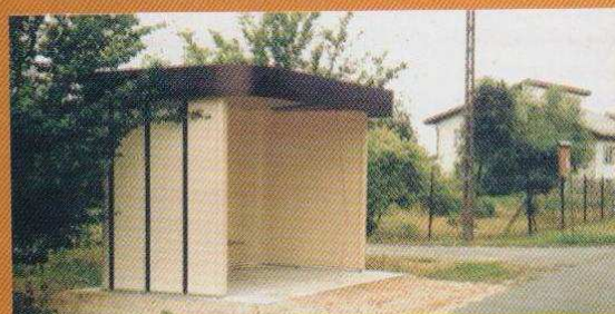
Nowa wiata przystankowa w miejscowości Cedrowice
