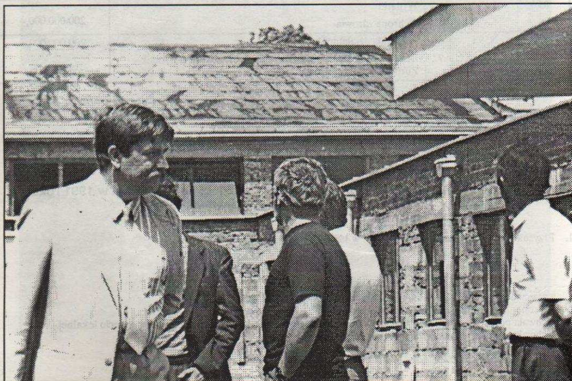
Sala gimnastyczna w Leśmierzu
