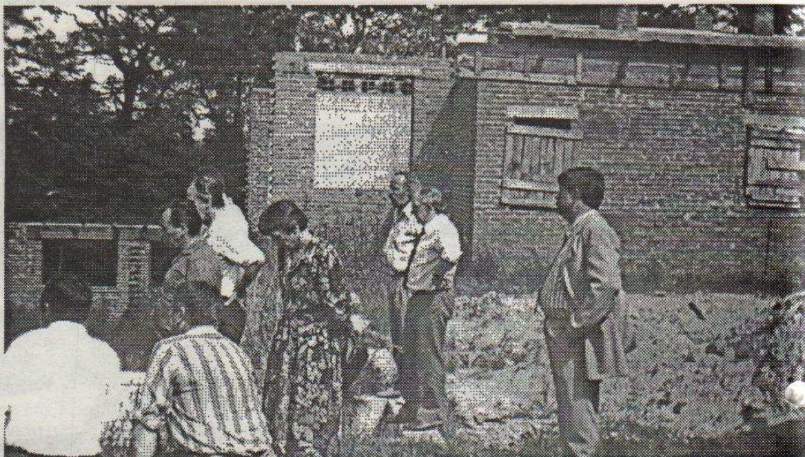
Budowa szkoły w Modłej
